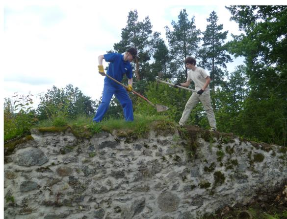
Die südliche Zwingermauer wird von Gras und Sträuchern im Kronenbereich gesäubert, damit bei der anstehenden Mauersanierung eine Abdichtungsschicht aufgebracht werden kann.
