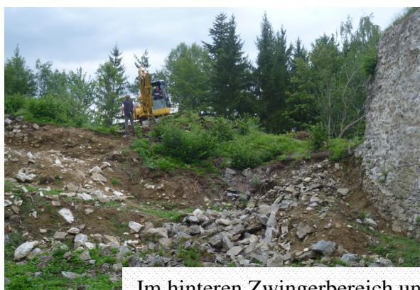
Im hinteren Zwingerbereich und über den Kellergewölben riss der Bagger die widerspenstigen Wurzelstöcke heraus.
