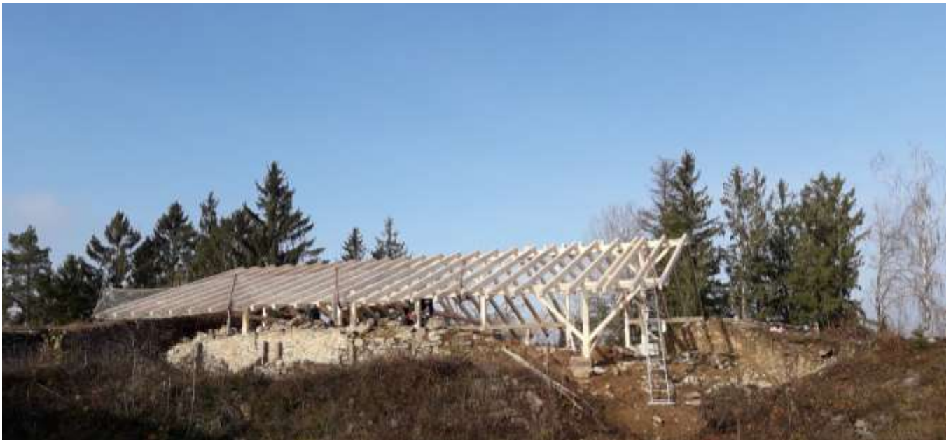
Das fertig aufgestellte Dach im Sonnenschein der Mittagssonne.
