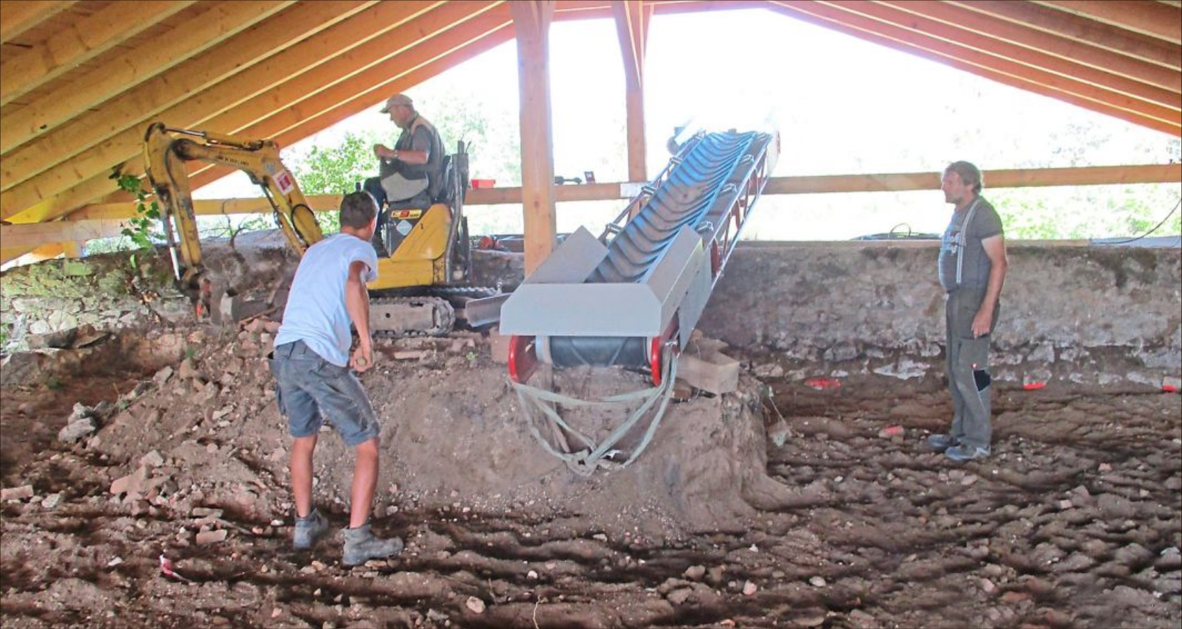
Im Palas wird Schutt entfernt.
