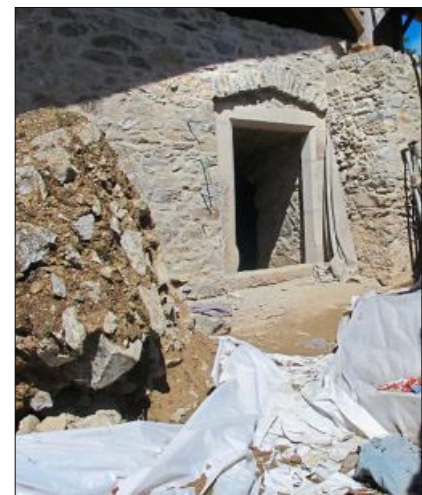
Vorratsraum mit neuer Kellertüre
