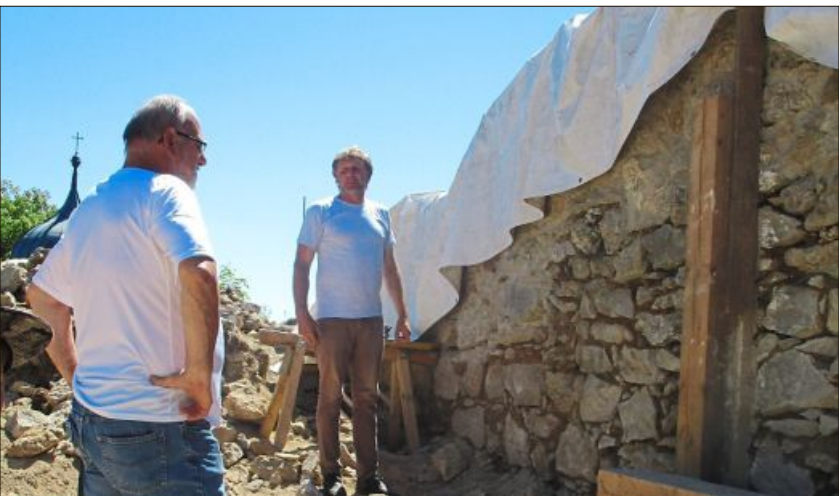
Diese Wand wurde freigelegt.
