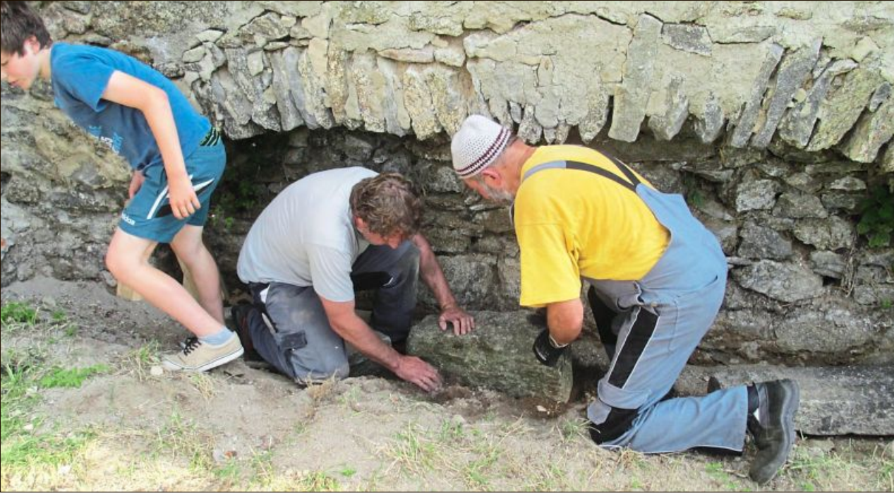
Dieses Gewölbe musste gestützt werden. Für die Arbeiten an und um die Burgruine sind stets viele Helfer im Einsatz.
