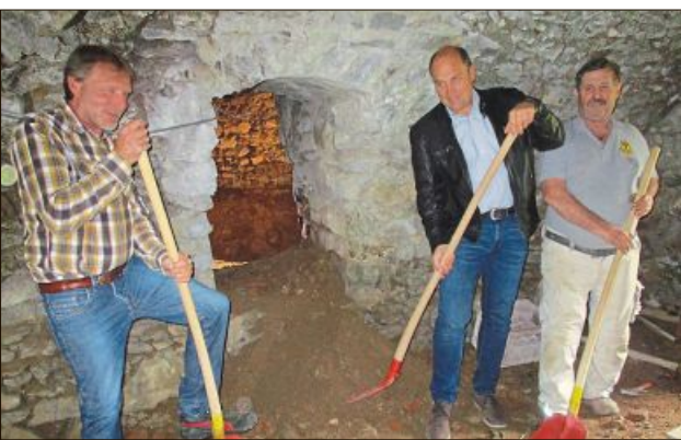
Spatenstich im „Keller“ – tatsächlich handelt es sich um das Erdgeschoss.
